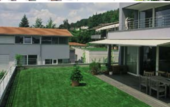
Intensive Dachbegrünung mit beispielbaren Rasen
