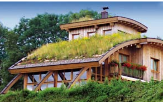
Extensive Steildach- begrünung
